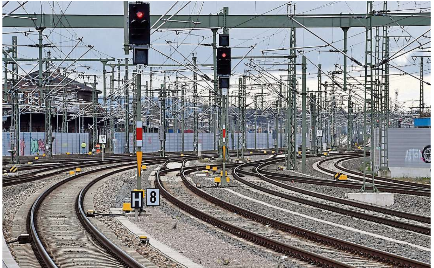
Vernetzte Rechner, elektronische Stellwerke – auf dem Foto ist der Bahnhof in Erfurt zu sehen: Eine Arbeitsgruppe, der Mitarbeiter der Deutschen Bahn und der TU Darmstadt angehören, erarbeitet Konzepte, um die Leit- und Sicherheitstechnik vor Cyberangriffen zu schützen. Foto: dpa
