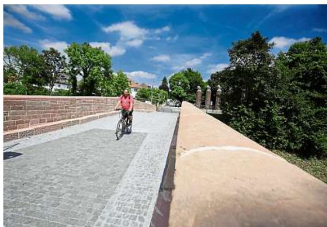
Kaum ist die Seiterswegbrücke wieder freigegeben, nutzen die ersten Radler den sanierten Übergang. Foto: Guido Schiek
