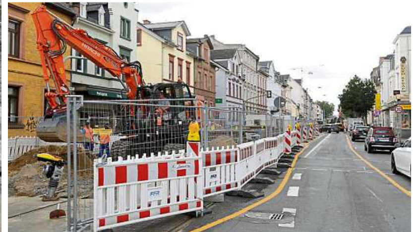
Großbaustelle: Mit schwerem Gerät wird der Beton zwischen den Straßenbahn-Gleisen in der Heidelberger Straße entfernt.
